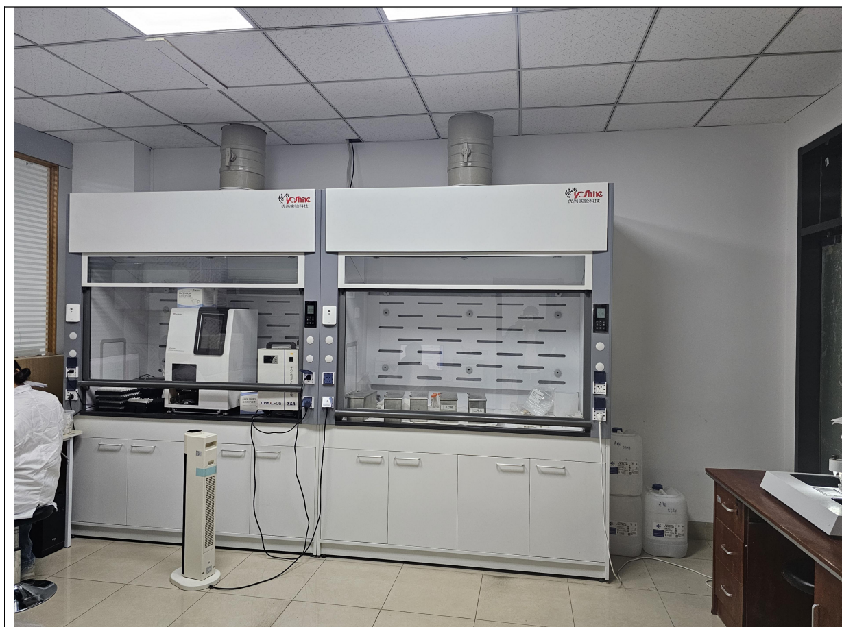
图 4.1 项目废气收集措施
