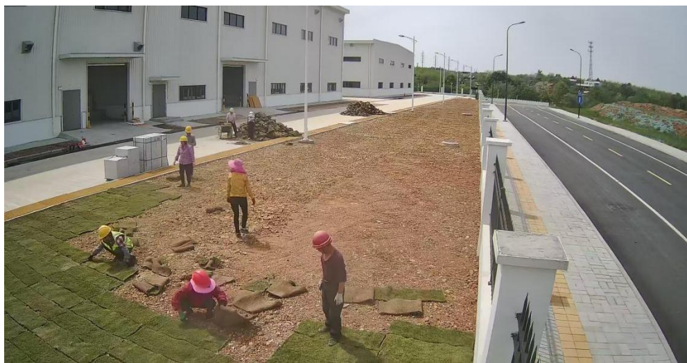
水土保持施工现场图
