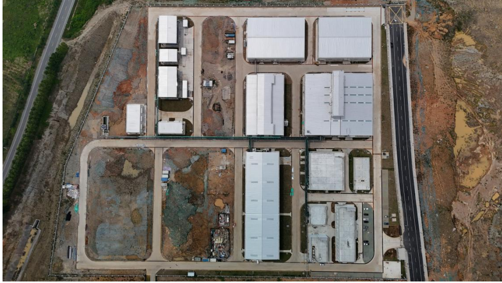
项目完工现场图
