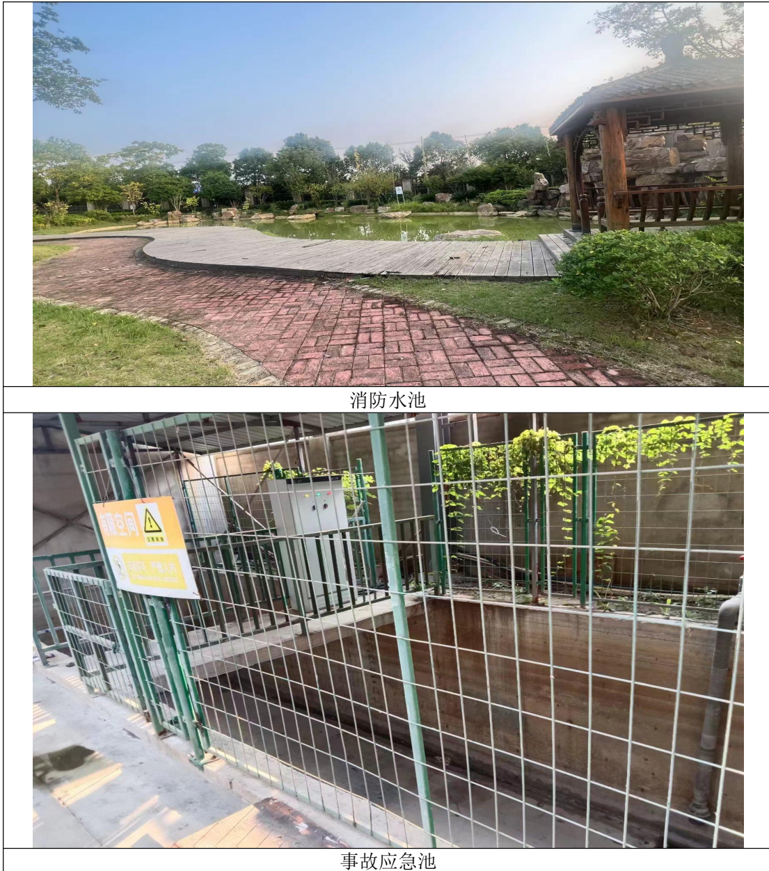
图 4.1-5 本项目消防水池、应急事故池设施现场图片
