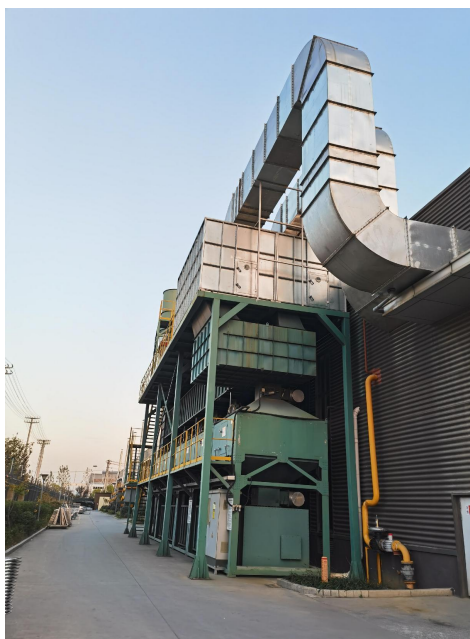
2#喷涂线废气处理设施（活性炭吸附+脱附+RCO 催化燃烧装置）
