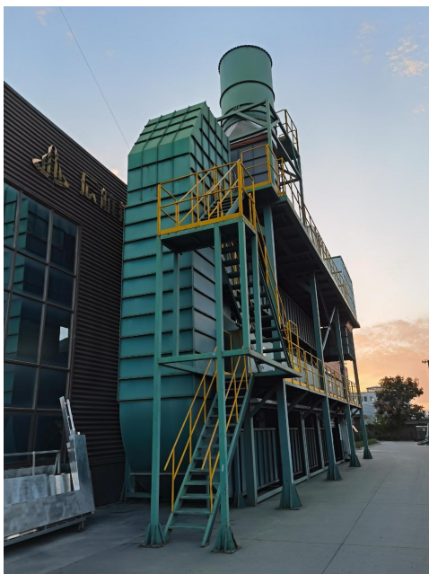
2#喷涂线废气处理设施（活性炭吸附+脱附+RCO 催化燃烧装置）
