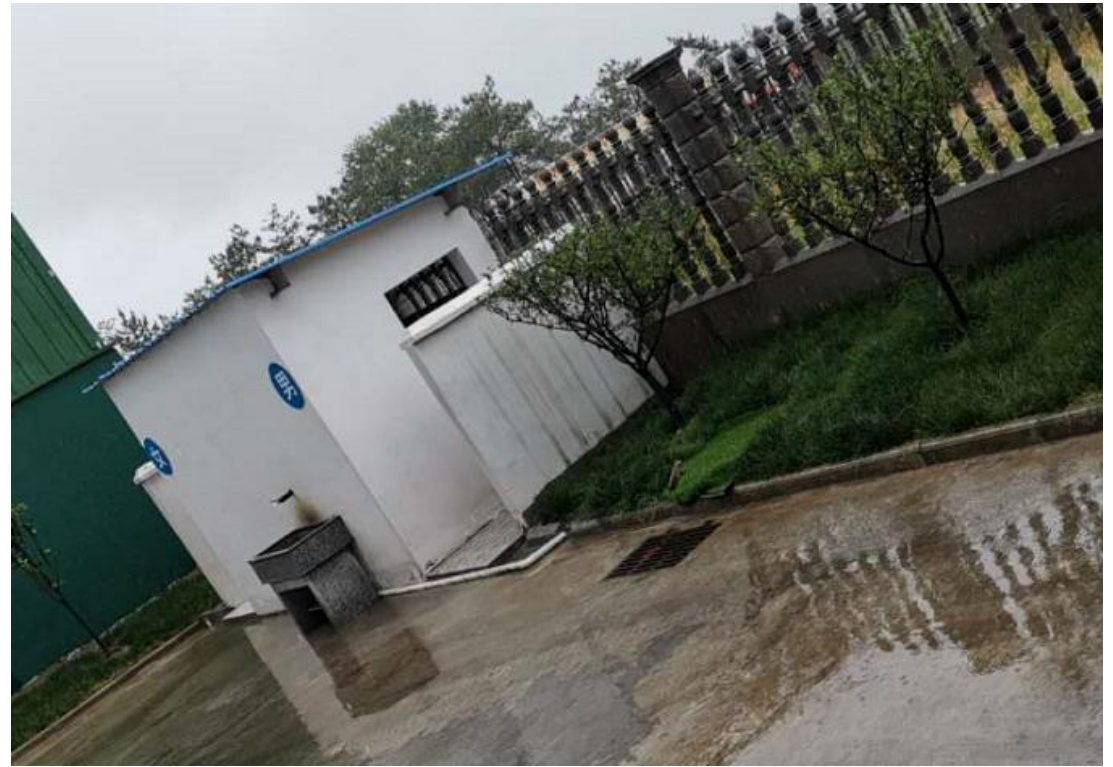
图 3 污水处理设施（化粪池）
